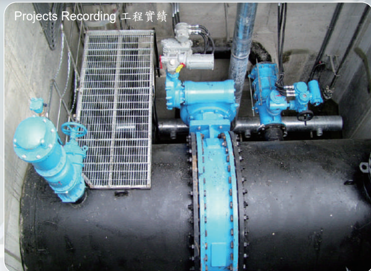
Hydraulic Actuator 油壓控制蝶閥
